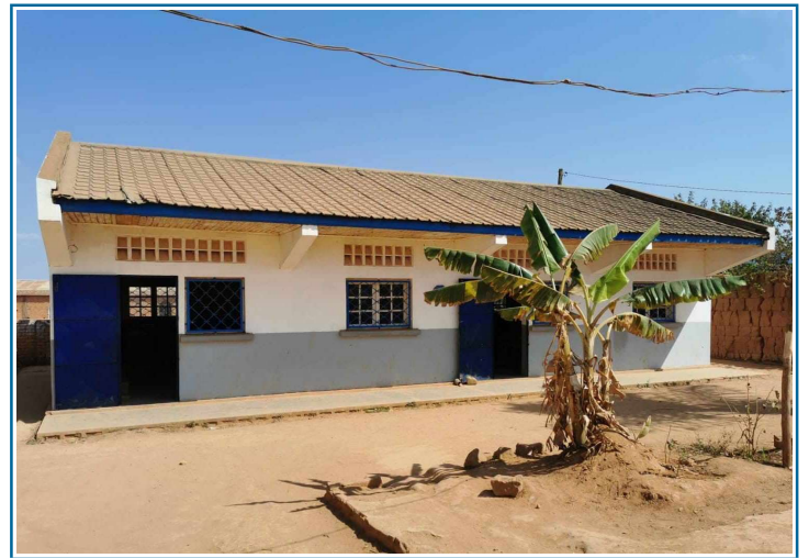
Remplacement des vitres cassées
